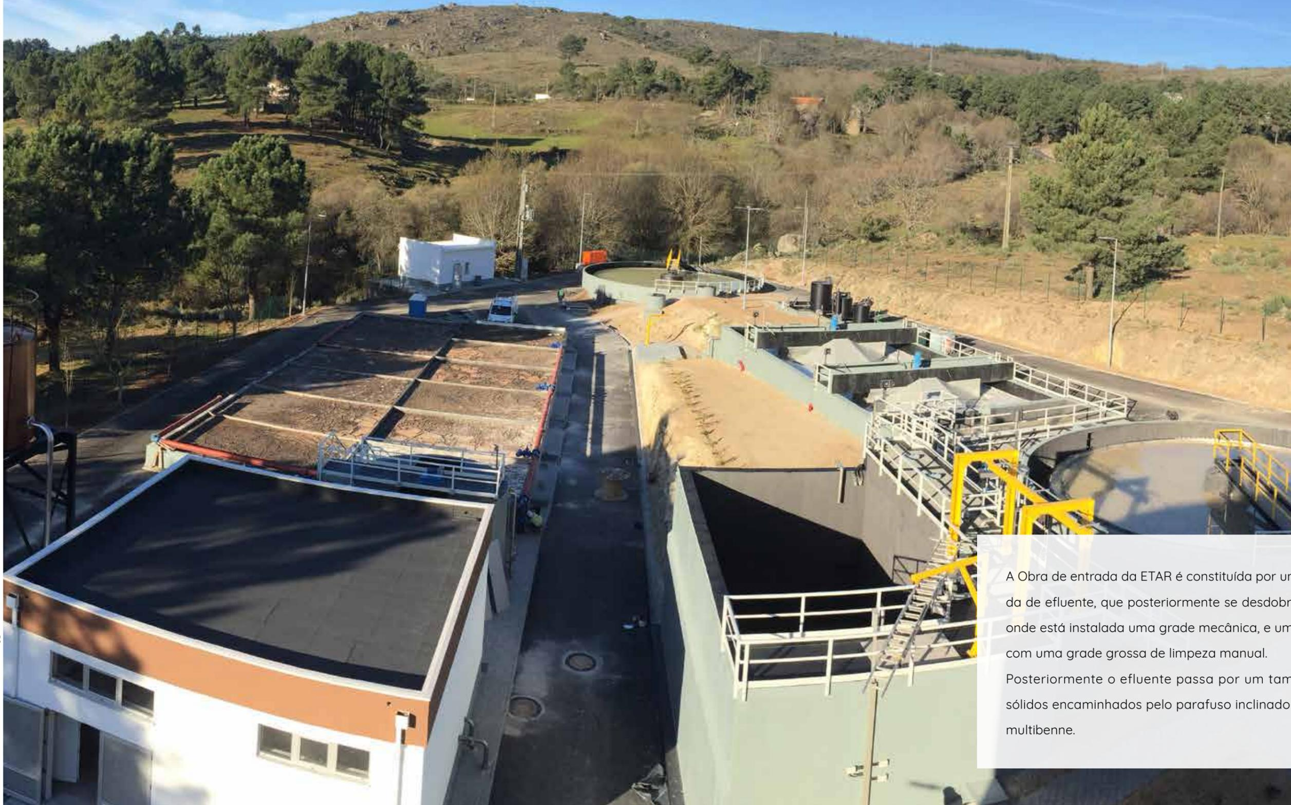
A Obra de entrada da ETAR é constituída por uma linha de entrada de efluente, que posteriormente se desdobra em duas linhas, onde está instalada uma grade mecânica, e uma outra equipada com uma grade grossa de limpeza manual. Posteriormente o efluente passa por um tamisador, sendo os sólidos encaminhados pelo parafuso inclinado para o contentor multibenne.
